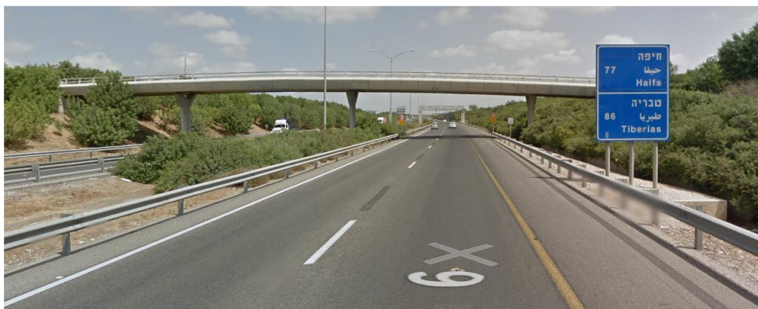
מעבר חקלאי עילי ברוחב 7.5 מטרים מעל כביש 6 באזור בת חפר. מקור: google street view
