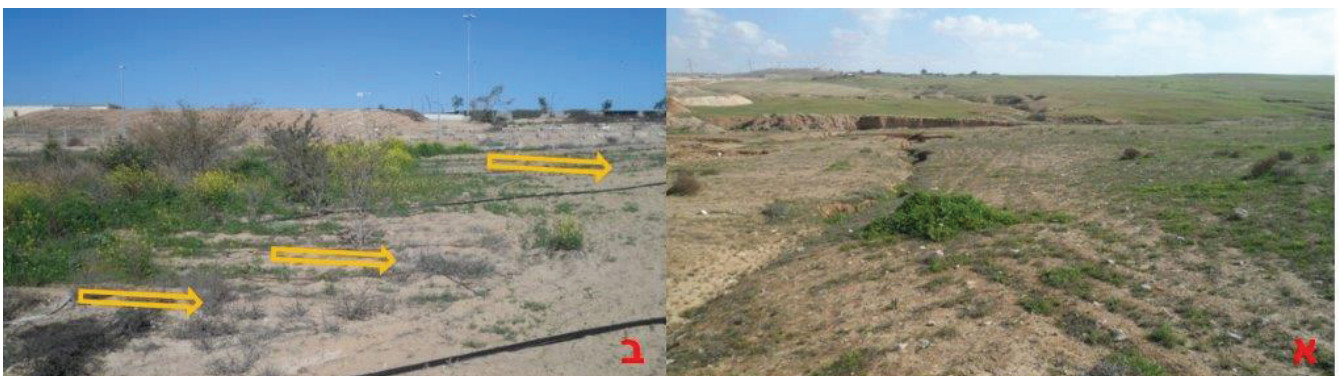
איור 5: שיקום שטח חרוש הסובל מסחף על ידי הקמת שרשרת לימנים לאורך משטח הזרימה, ואדי עתיר, פברואר 2016 א. שטח חרוש סמוך המצוי בהתחלת אינטנסיביות שלא עבר טיפול לעצירתה
